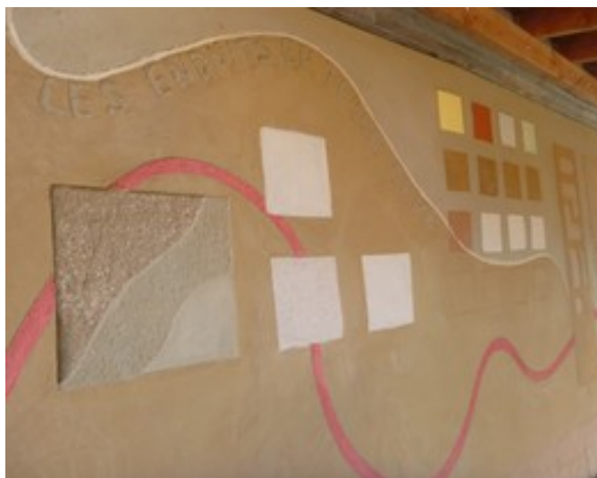
Mur démonstratif de différents enduits terre (Écocentre® Pierre & Terre)
