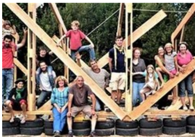
Chantier participatif à l'Écocentre® du Trégor
