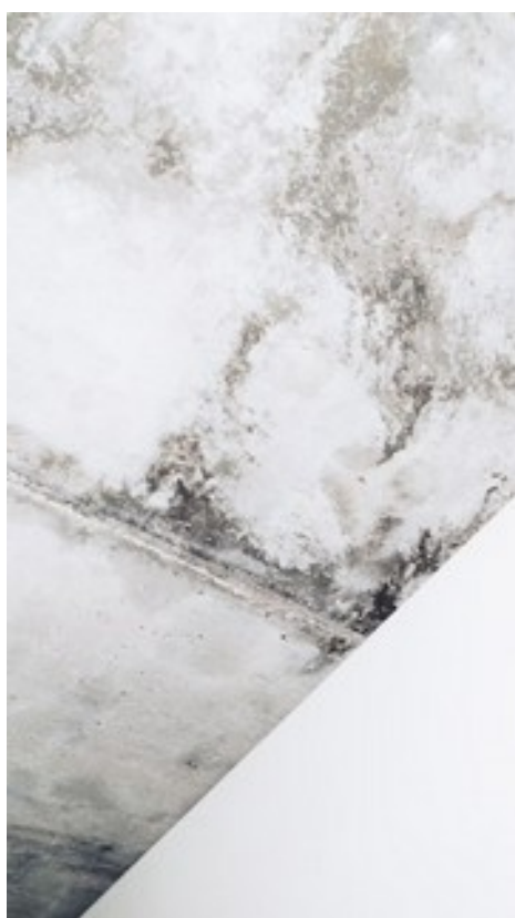
Moisissures dans un logement non-ventilé
