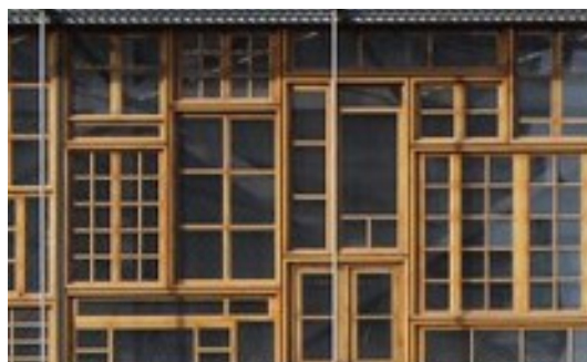
Façade vitrée en fenêtres de réemploi (Siège du Conseil de l'UE)
