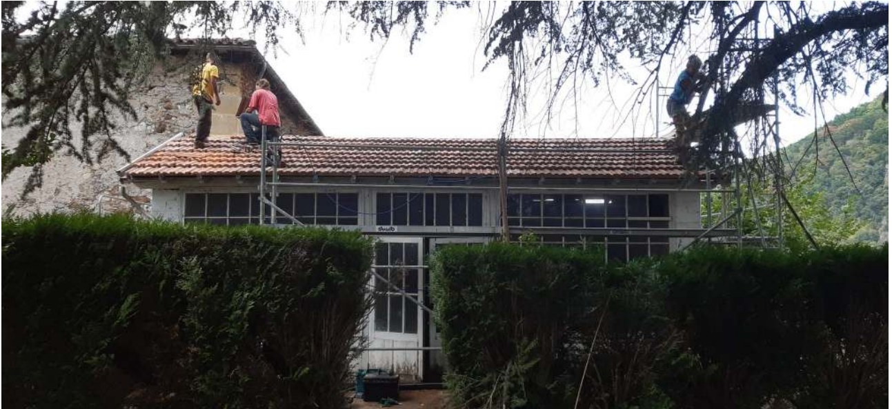
Chantier de bénévoles : Réfection de la toiture
