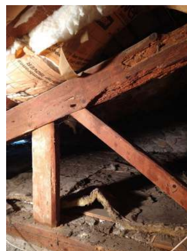
Ci-contre, l'ancienne isolation avant dépose
