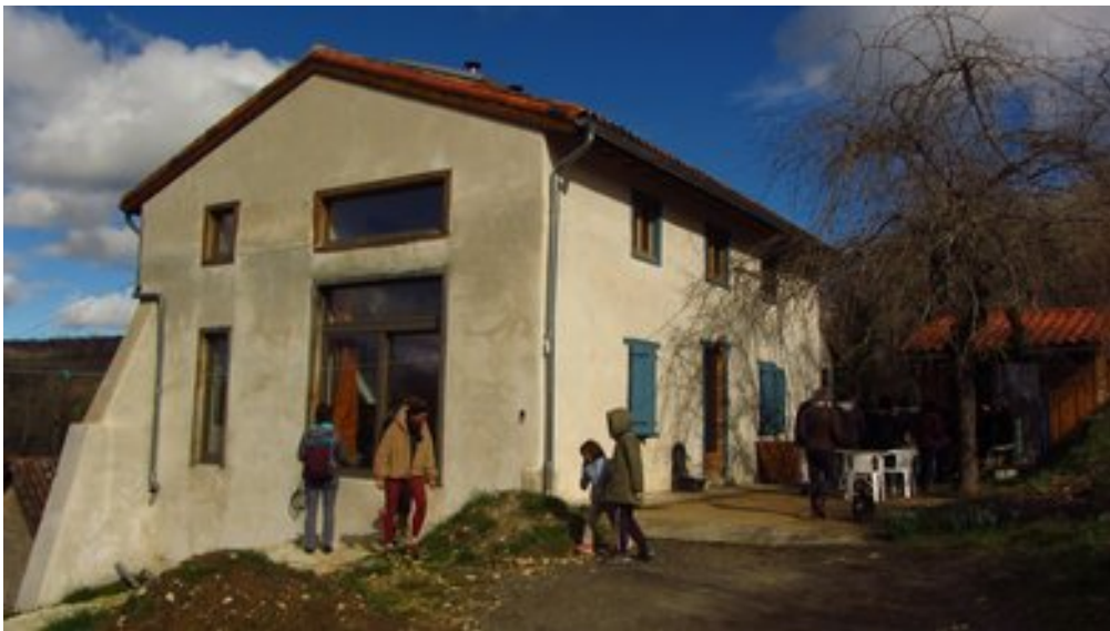
Rénovation et surélévation à Tourtouse
