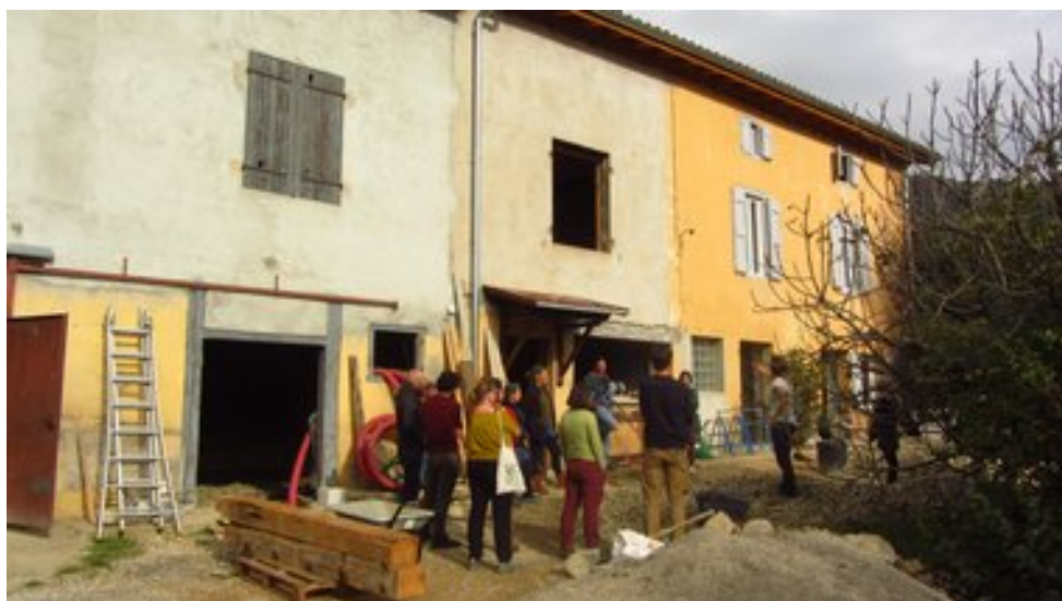
Visite de chantier d'une rénovation groupée, à Foix
