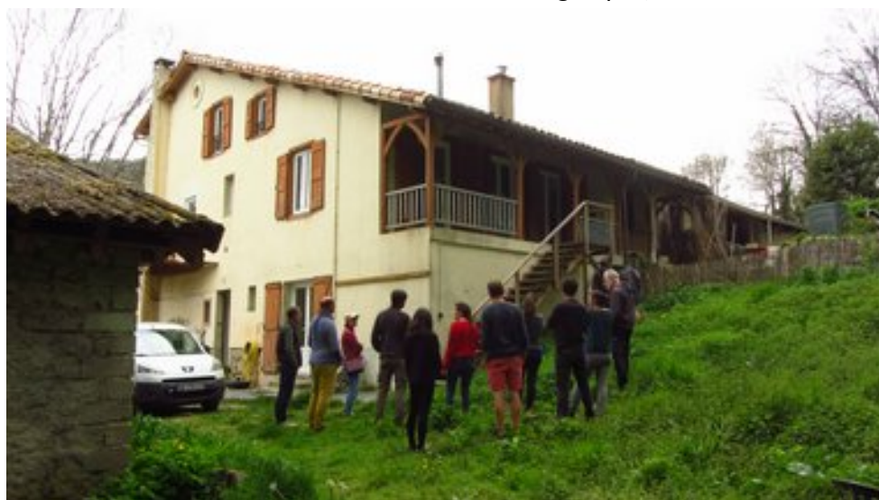
Rénovation et enjeux sur l'isolation phonique, à Arabaux
