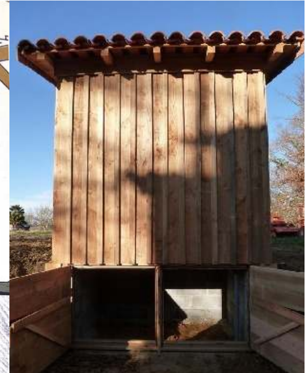
Système WC sèches reliées à un composteur © photos : Pierre & Terre
