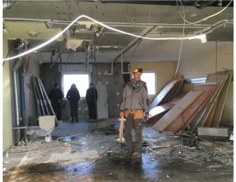
Dépose selective de l'ancien hopital de St Gaudens © photos : ZAI
