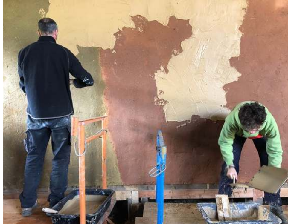
Formation enduit Terre © photos : Association Écorce
