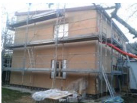
Rénovation performante à Foix avec ITE
