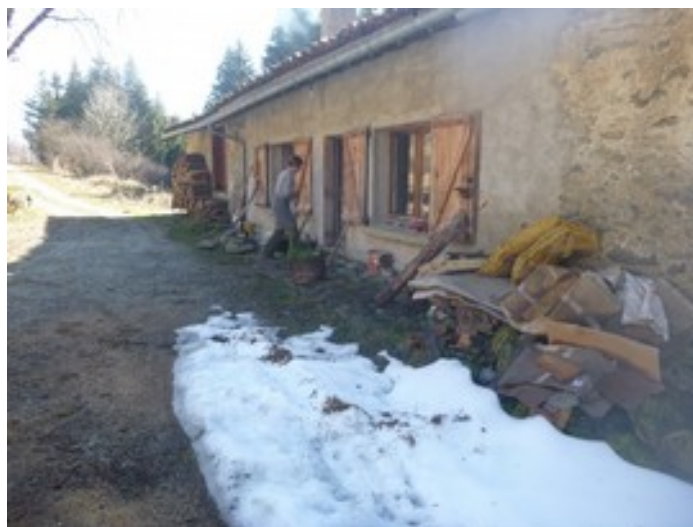
Maison en forêt à Fougax qui nécessitait de lourds travaux de rénovation thermique.
